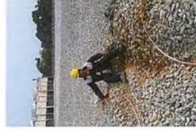
Block 1 อาคารเก็บก๊าซ N2&Co2 ขณะทำการติดตั้ง ดอกล่างกรวดทองแดง สายล่อฟ้า
