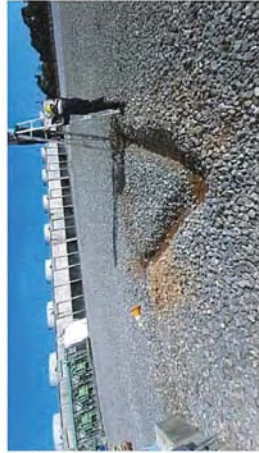
Block 1 อาคารเก็บก๊าซ N2&Co2 ขณะทำการติดตั้ง ชุดสิ่งแห่งกรวดทองแดง สายล่อฟ้า
