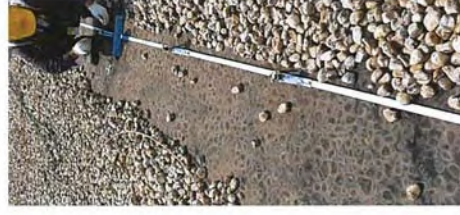
Block 1 อาคารเก็บก๊าซ N2&Co2 ขณะทำการติดตั้ง Support ยึดฐานทองแดง เปลือย 50 Sqmm.
